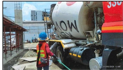
รูปที่ 14 จุดล้างล้อรถบริเวณทางเข้า-ออกโครงการ
