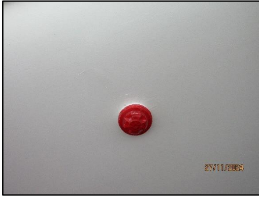
รูปที่ 57 อุปกรณ์ตรวจจับควันไฟและความร้อน
