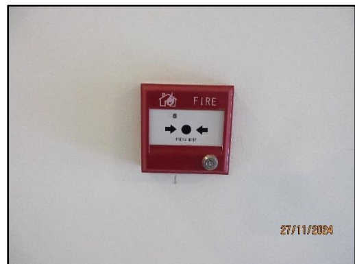
รูปที่ 56 ระบบสัญญาณแจ้งเหตุเพลิงไหม้
