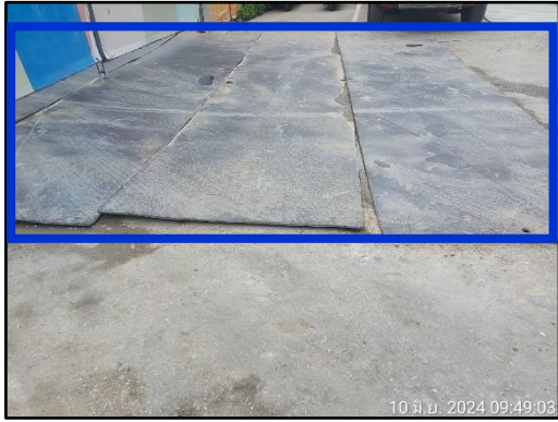
รูปที่ 82 แผ่นเหล็กรองรับเครื่องจักร
