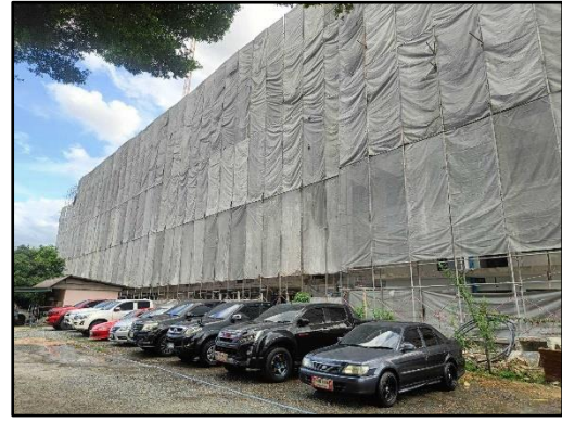
รูปที่ 12 ติดตั้งผ้าใบก่อสร้าง Mesh Sheet (ชนิดกันไฟลาม)
