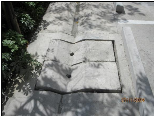
รูปที่ 44 ร่องระบายน้ำและท่อระบายน้ำภายในพื้นที่โครงการ
