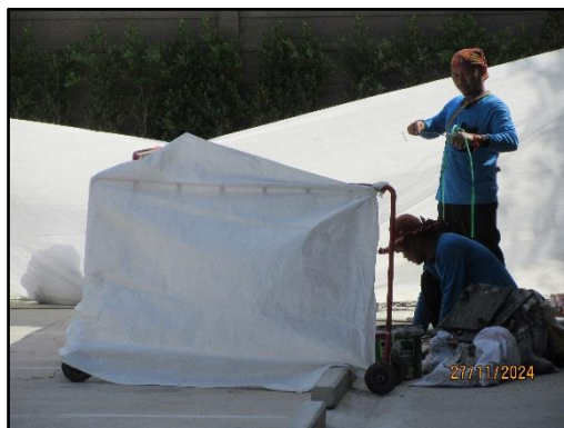
รูปที่ 13 ใช้ผ้าใบกันกิจกรรมที่อาจก่อให้เกิดฝุ่น
