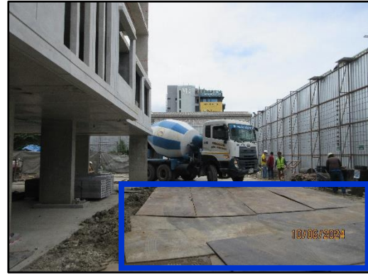
รูปที่ 82 แผ่นเหล็กรองรับเครื่องจักร
