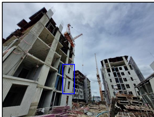
รูปที่ 24 ผนังคอนกรีตสำเร็จรูป
