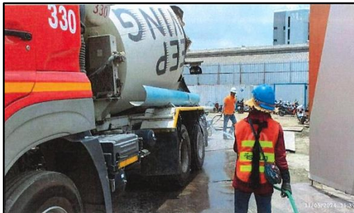
รูปที่ 14 จุดล้างล้อรถบริเวณทางเข้า-ออกโครงการ
