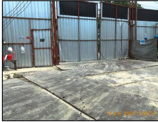
รูปที่ 14 จุดล้างล้อรถบริเวณทางเข้า-ออกโครงการ
