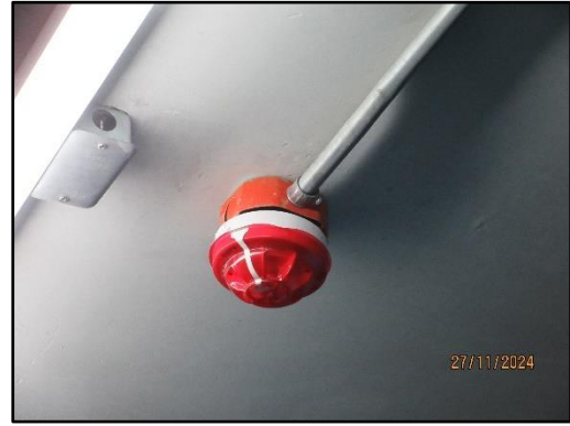
รูปที่ 57 อุปกรณ์ตรวจจับควันไฟและความร้อน
