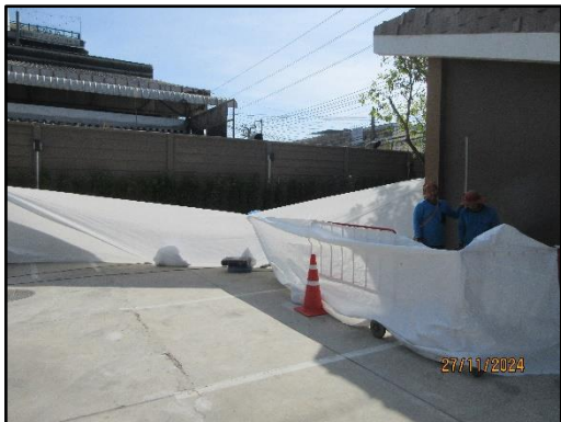
รูปที่ 12 ติดตั้งผ้าใบก่อสร้าง Mesh Sheet (ชนิดกันไฟลาม)
