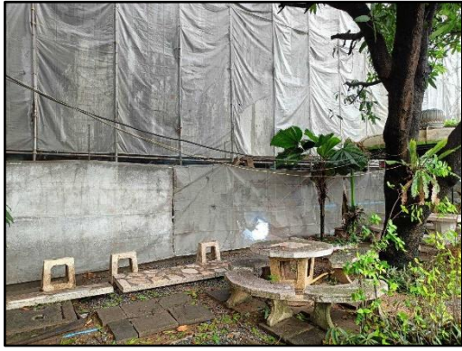
รูปที่ 12 ติดตั้งผ้าใบก่อสร้าง Mesh Sheet (ชนิดกันไฟลาม)
